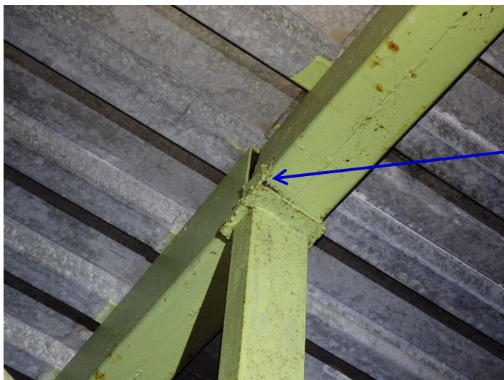
nekvalitně provedené uložení vaznice na sloupek (vybraná ukázka)
